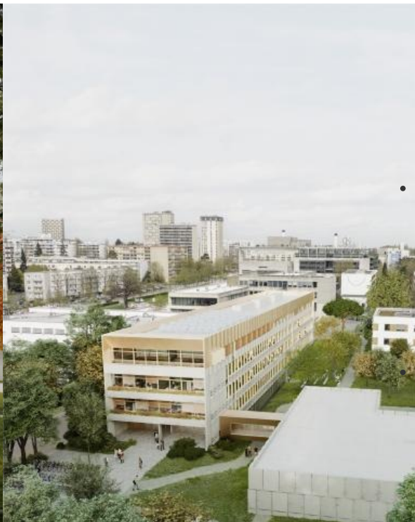
Bât A - Vue aérienne - Atelier Robain Guieysse - © Jeudi Wang
